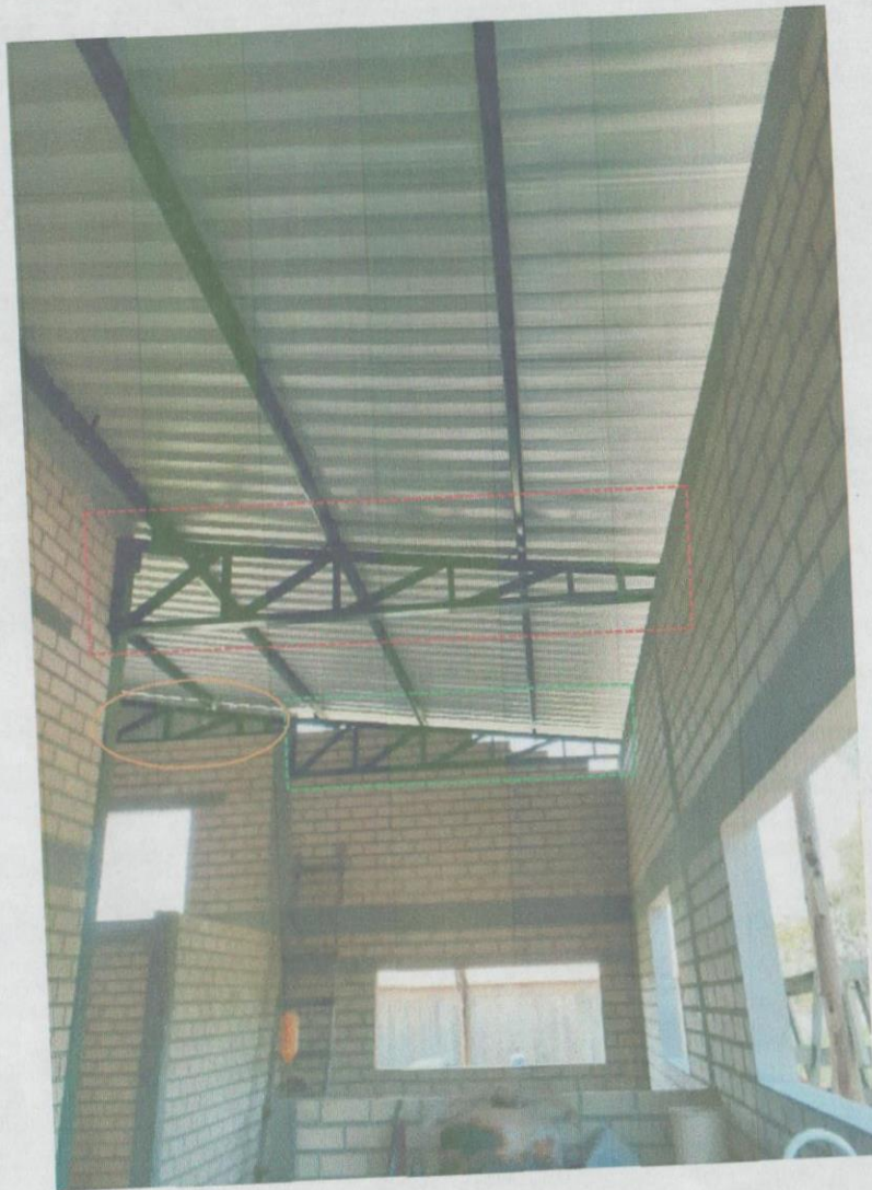
Vista da frente para os fundos da cozinha (aparecem 2 vigas de 4 metros e parte da viga de 12 metros)
