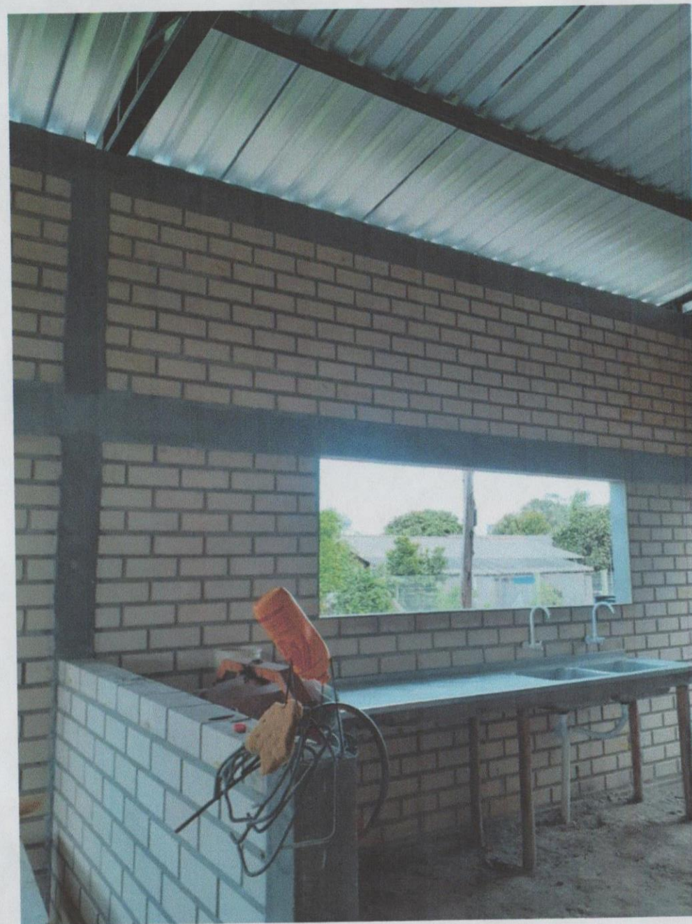
TELHADO DA COZINHA
