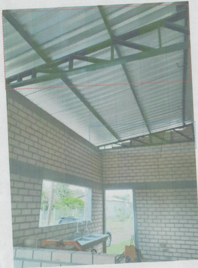
Vista dos fundos para a frente da cozinha (aparecem a mesma viga de 4 metros do meio e a outra da frente)
