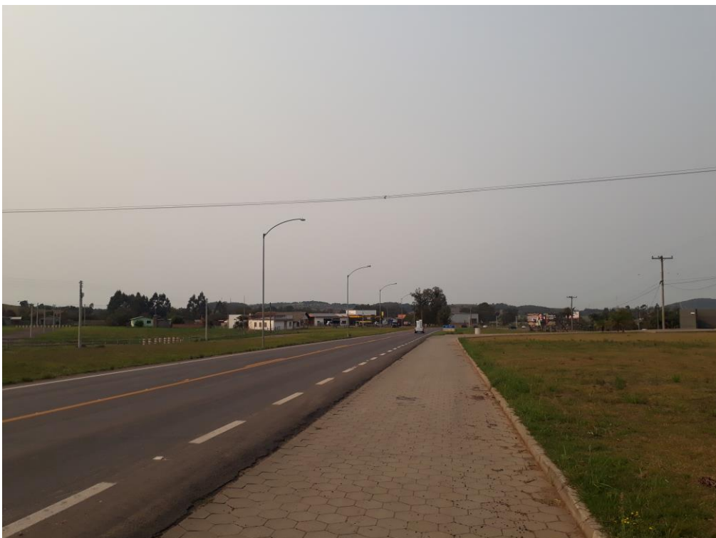
Fotos sentido norte/sul, em direção à Rodovia Osvaldo Aranha – BR-290
